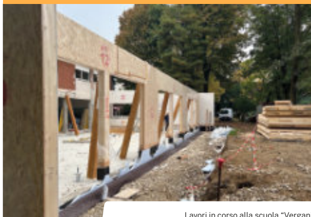
Lavori in corso alla scuola "Vergani"
