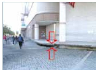
Figura 7.7: Subsidenza di 45 cm del terreno di fronte ad un centro commerciale ad Urayasu City (Giappone 2011)
