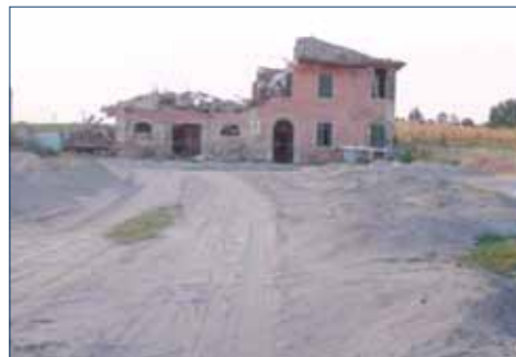
Figura 7.14: Esempi di liquefazione (terremoto Emilia-Romagna 2012)
