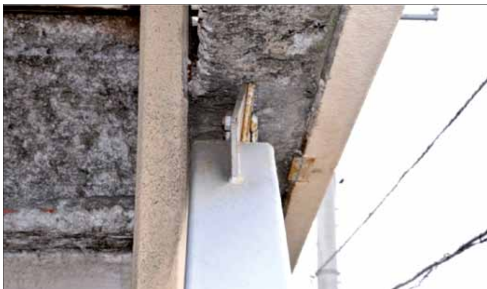
Figura 5.41: Instabilizzazione di un fazzoletto metallico utilizzato per il collegamento telaio - diagonale di controvento. Livello di danno: D2 – D3 (terremoto di Tohoku, Giappone 2011)
