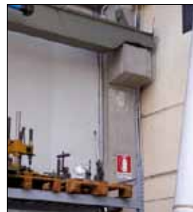
Figura 5.8: Martellamento tra trave porta-carroponte e pannello tagliafuoco di compartimentazione tra zona produttiva e zona uffici di un capannone industriale. Livello di danno: D2 – D3 (terremoto Emilia-Romagna 2012)
