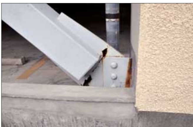
Figura 5.42: Rottura di un fazzoletto metallico a cui è collegato un diagonale di controvento di un parcheggio. Livello di danno: D4 (terremoto di Tohoku, Giappone 2011)
