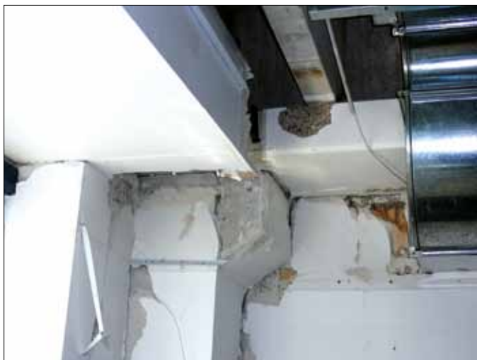
Figura 5.19: Danneggiamento locale nel pilastro e nella mensola di un edificio a struttura prefabbricata. Livello di danno nella connessione trave-pilastro: D3 (terremoto Abruzzo 2009).
