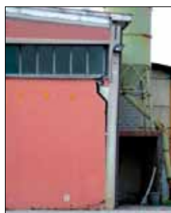
Figura 5.10: Spostamento residuo del pilastro in seguito alla formazione di cerniera plastica alla base. Livello di danno: D4 (terremoto Emilia-Romagna 2012)
