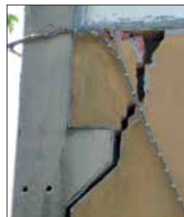
Figura 5.9: Fuori piombo dei pilastri di un edificio monopiano prefabbricato per possibile, ma non accertato, problema a livello della fondazione. Livello di danno: D4 (terremoto Emilia-Romagna 2012)
