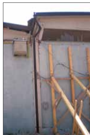
Figura 5.16: Perdita di appoggio della trave di copertura di un edificio monopiano prefabbricato a causa della crisi a taglio del pilastro di appoggio avvenuta in corrispondenza della variazione di rigidezza causata dai tamponamenti non a tutta altezza. Livello di danno nella connessione trave-pilastro: D4 - D5 (terremoto Emilia-Romagna 2012)
