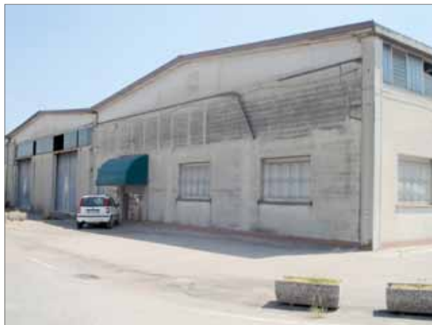
Figura 4.29. Struttura prefabbricata monopiano con tamponatura in laterizio.
