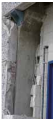
Figura 5.33: Rottura dello spigolo del pannello per insufficiente armatura ed effetto di martellamento. Livello di danno: D3 (terremoto Abruzzo 2009, Centro commerciale, L'Aquila)
