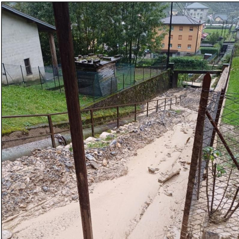
***Figura 25 – Colata detritica lungo il canale Enel***
