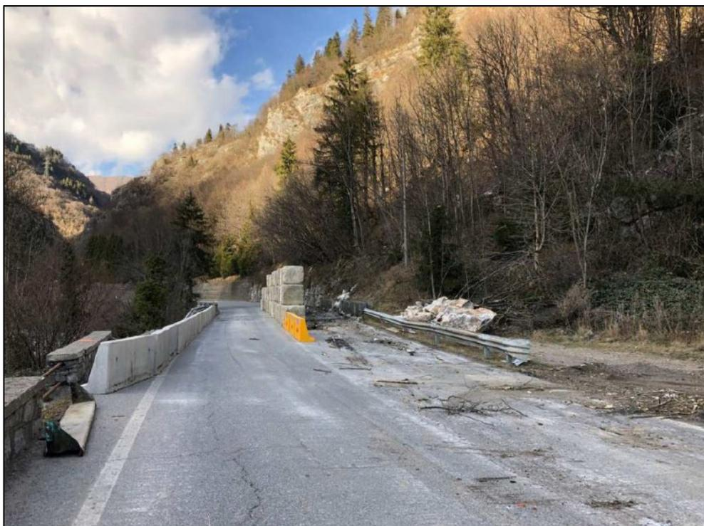
**Figura 7 – Opere di protezione temporanea lungo la SP 49 per la parziale riapertura del tratto di strada (da relazione dott. Geol. Anna Cantoni, 2019)**
