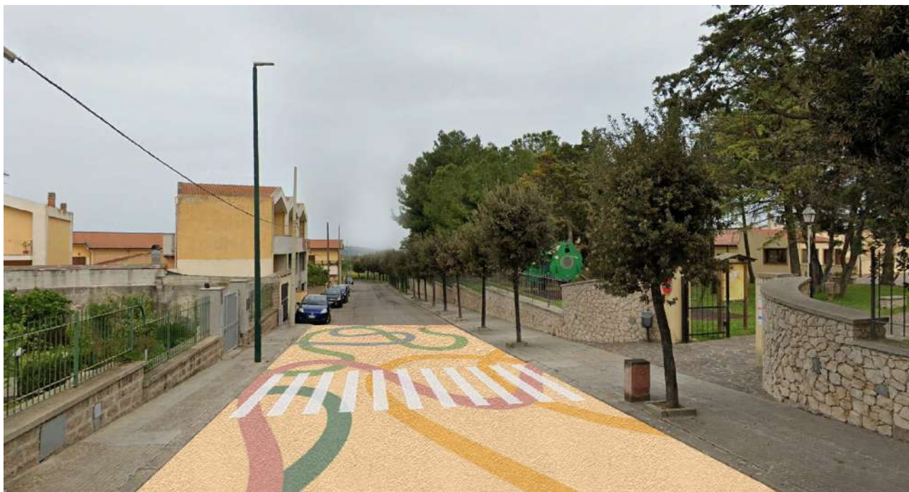
Stampa e colorazione asfalto
