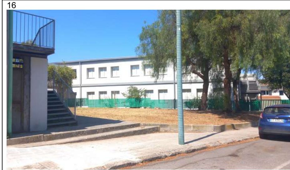
16 Via de Idda, assenza scivolo per raccordo del nel percorso pedonale
