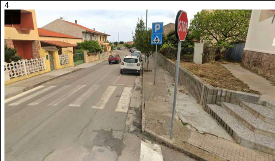
4 Attraversamento pedonale adiacente via de Idda, assenza raccordi
