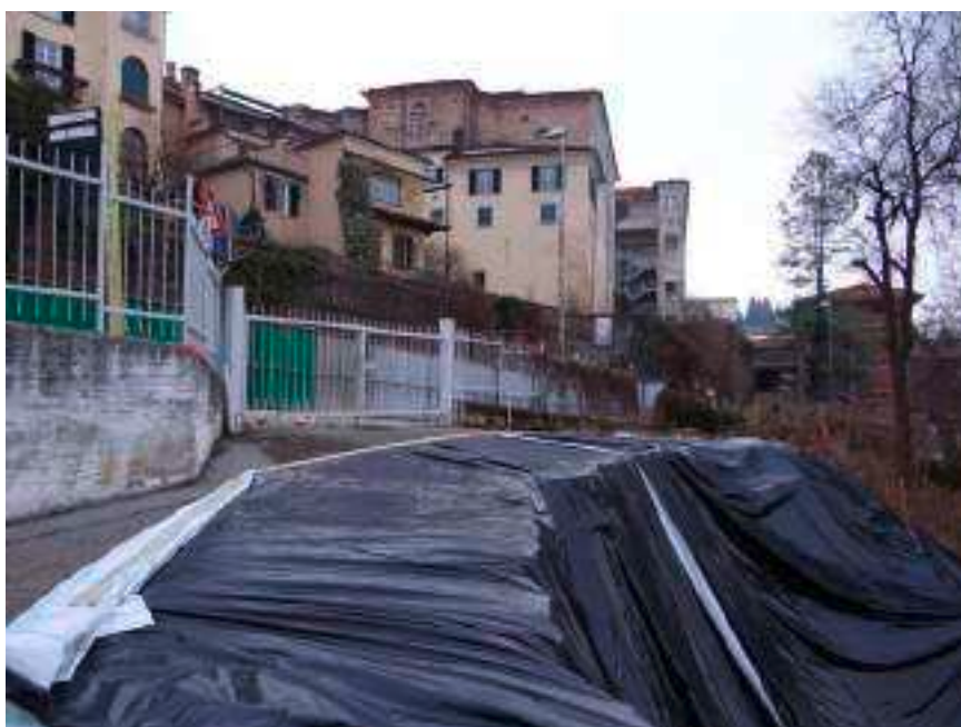
Immagine 10 - 2018_01_05-Intervento di protezione della parte sommitale della frana nei riguardi degli agenti atmosferici
