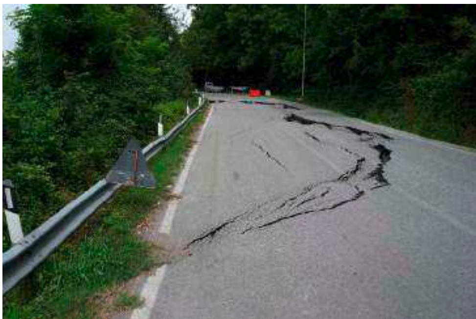
Immagine 06 - 23/06/2014-Aggravamento del movimento al piede settentrionale dell'accumulo
