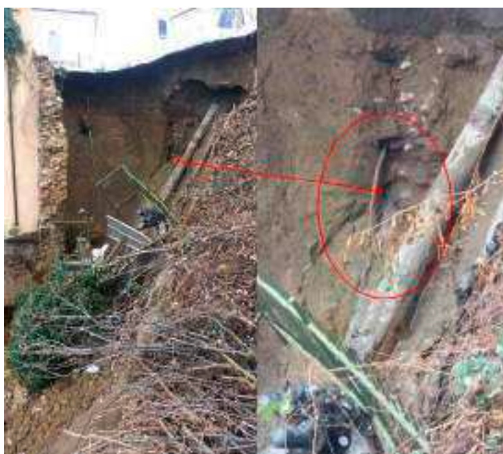
Immagine 02 - 2017_12_29-Venuta d'acqua concentrata sulla scarpata principale di frana (fotografie scattate verso le ore 13.00 dai Vigili del Fuoco)
