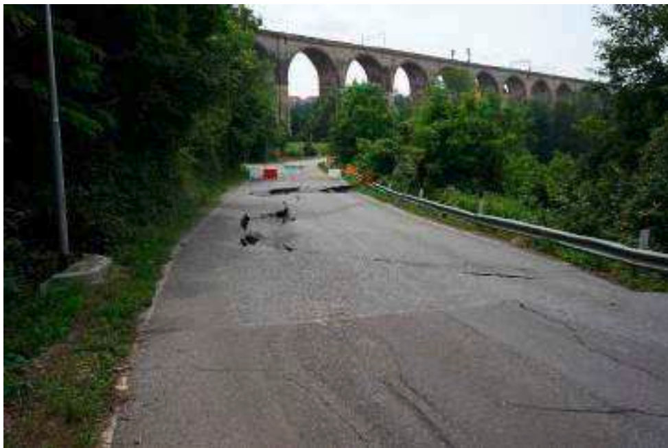
Immagine 05 - 23/06/2014-Aggravamento del movimento al piede settentrionale dell'accumulo
