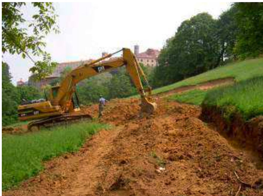
Immagine 01 - 2004_05_21-Interventi di sistemazione della frana
