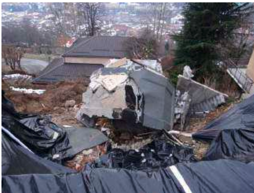
Immagine 11 - 2018_01_05-Intervento di protezione della parte sommitale della frana nei riguardi degli agenti atmosferici, fotografia scattata dal coronamento
