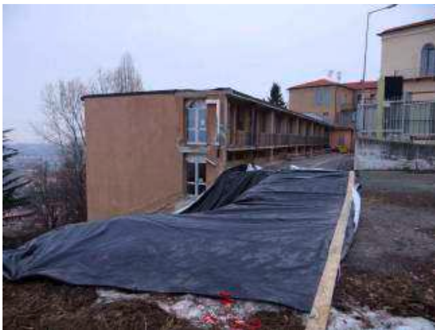
Immagine 09 - 2018_01_05-Intervento di protezione della parte sommitale della frana nei riguardi degli agenti atmosferici
