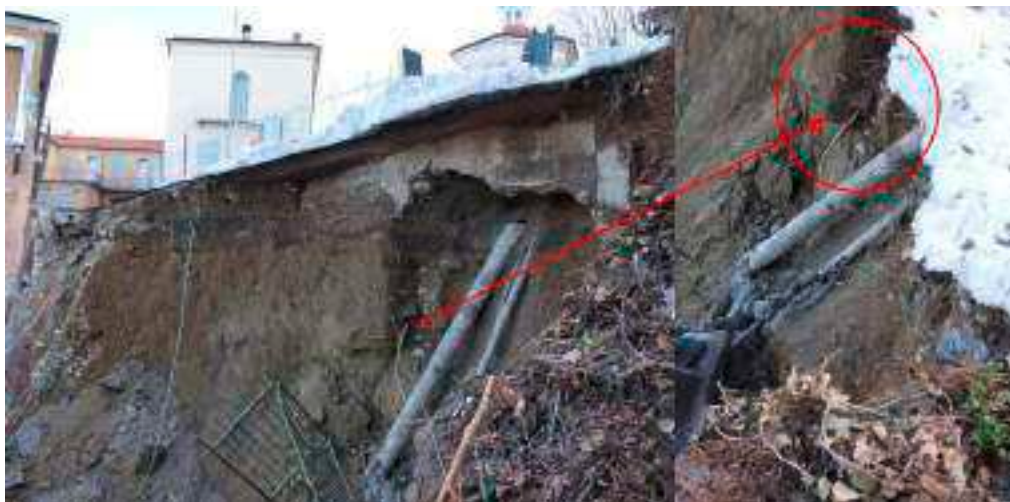
Immagine 03 - 2017_12_30-Situazione del fronte di frana alle ore 9.00, assenza di emergenze idriche
