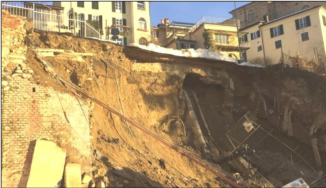
Figura 6 –Vista della nicchia di distacco.
