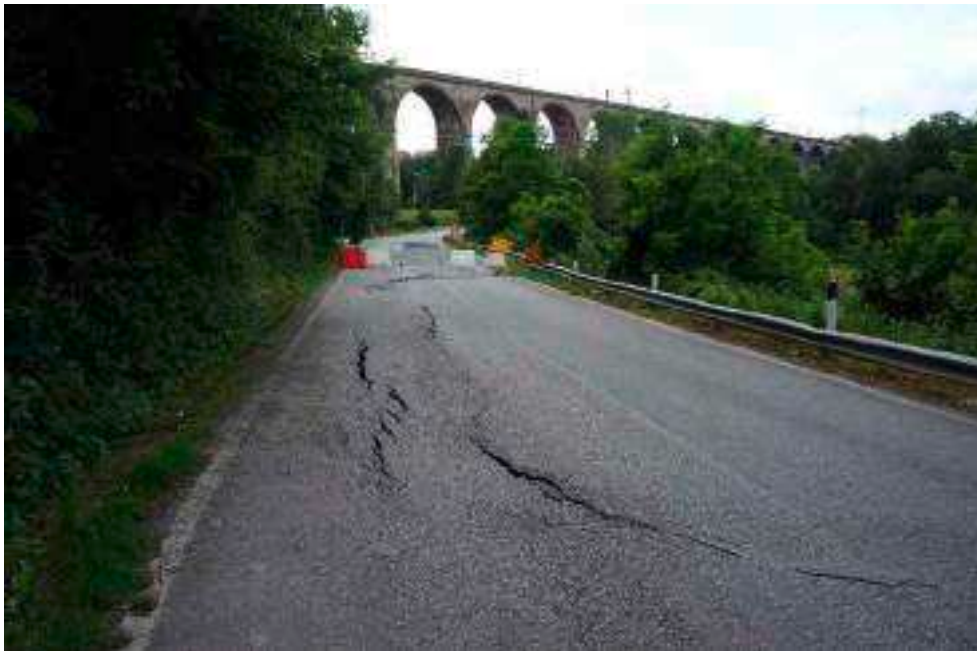
Immagine 04 - 18/06/2014-Movimento al piede settentrionale dell'accumulo
