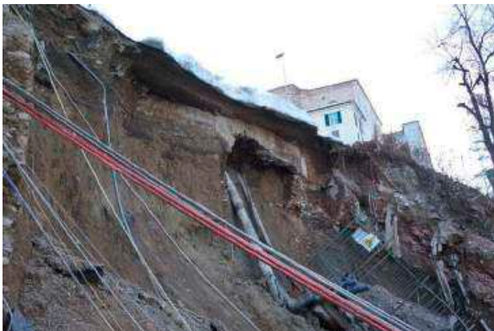
Immagine 07 - 2017_12_30-Scarpata di coronamento, evidente lo scavernamento in corrispondenza di sottoservizi di varia tipologia
