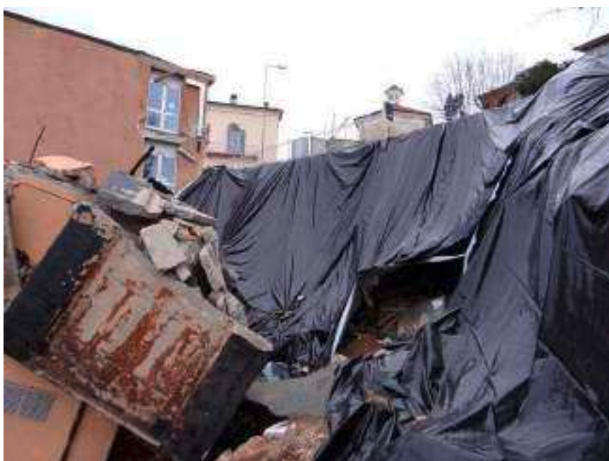
Immagine 12 - 2018_01_05-Intervento di protezione della parte sommitale della frana nei riguardi degli agenti atmosferici, fotografia scattata in direzione del coronamento
