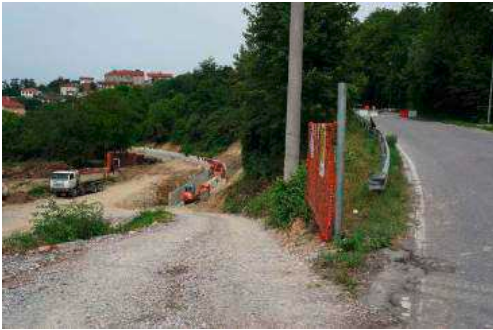
Immagine 07 - 23/06/2014-Lavori al piede del versante per la realizzazione della condotta di una nuova centralina idroelettrica
