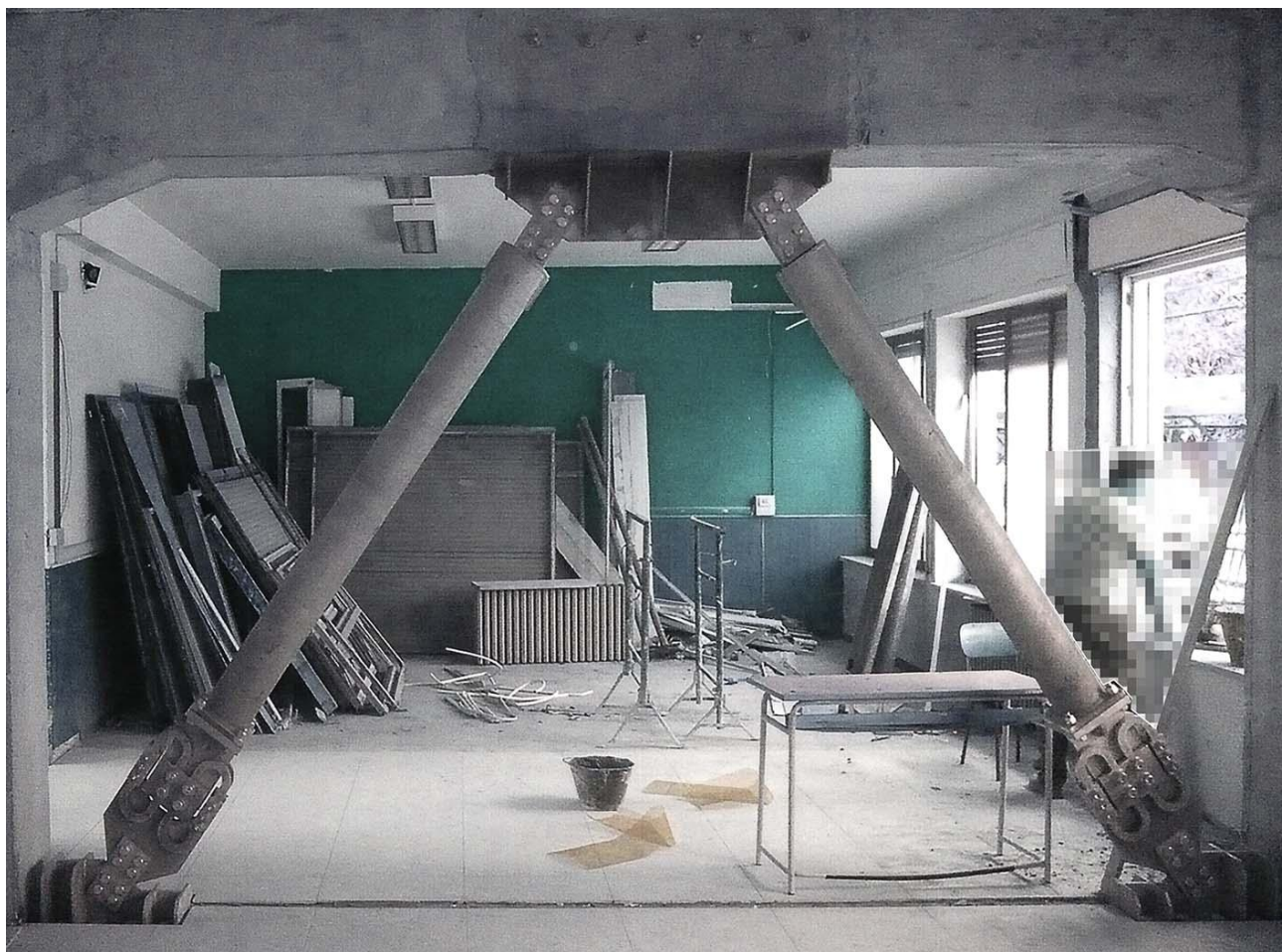
Installazione di controventi dissipativi
