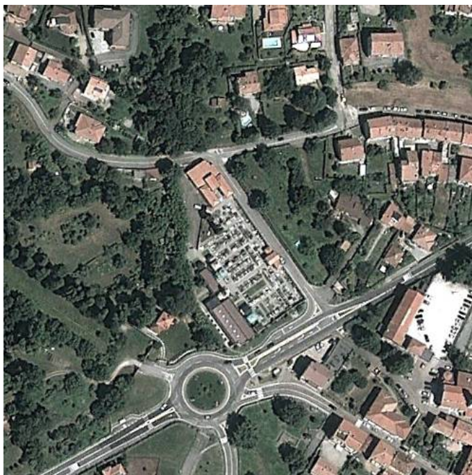
Vista aerea del cimitero di Comerio
