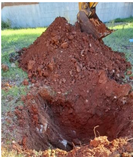
Fig. 14 Pozzetto geognostico Pz2
