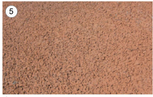
Calcestruzzo drenante percorsi ciclabili
