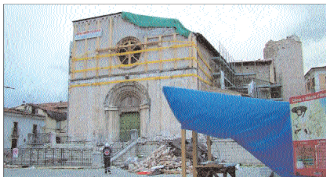
Opere di ricostruzione degli edifici danneggiati dal terremoto
