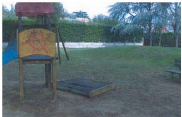
Scaletta in legno per salire sullo scivolo “strappata e bruciata”
