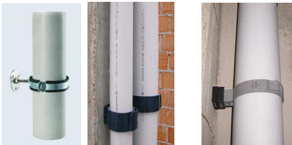
Figura 20 – Esempio di fissaggio delle tubazioni idriche
