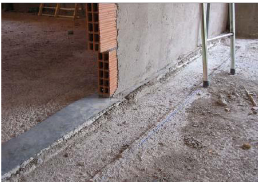
Figura 2 – Applicazione delle fasce tagliamuro
