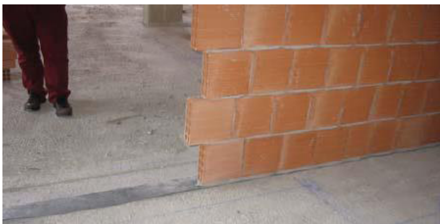
Figura 1 – Applicazione delle fasce tagliamuro
