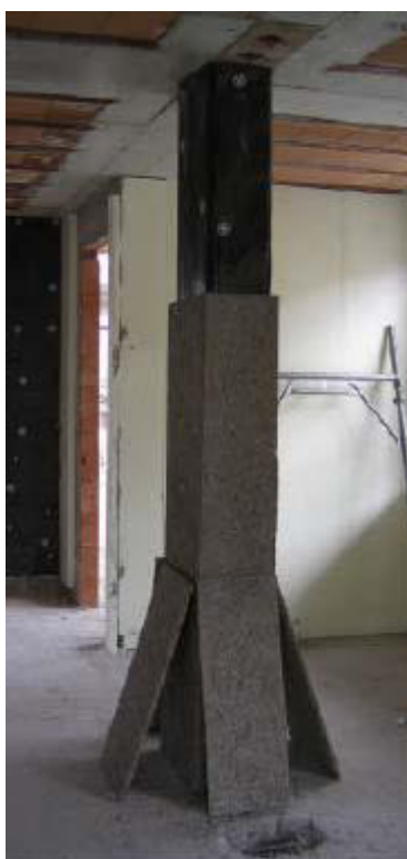
Figura 9 – Isolamento di un pilastro con polietilene reticolato
