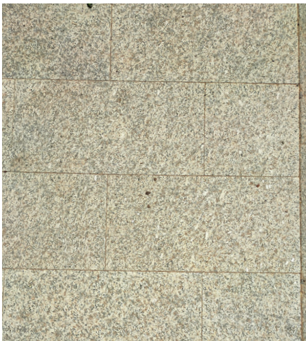
Pavimentazione in lastre di granito.
