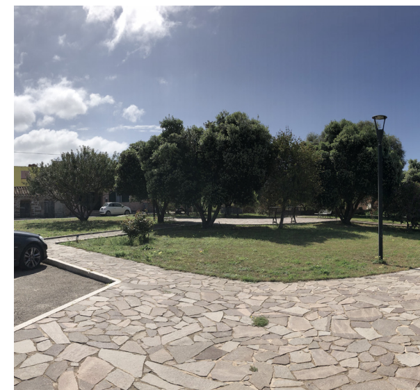
Pavimentazione in lastre di basalto, messa in opera opus incertum.
