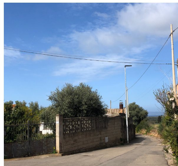
Pavimentazione in conglomerato bituminoso.
