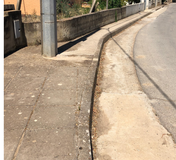
Pavimentazione con marciapiedi in lastre cementizie, carreggiata in conglomerato bituminoso e cunette in calcestruzzo.
