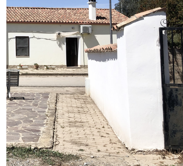
Marciapiedi con pavimentazione in mattonelle sagomate cementizie.
