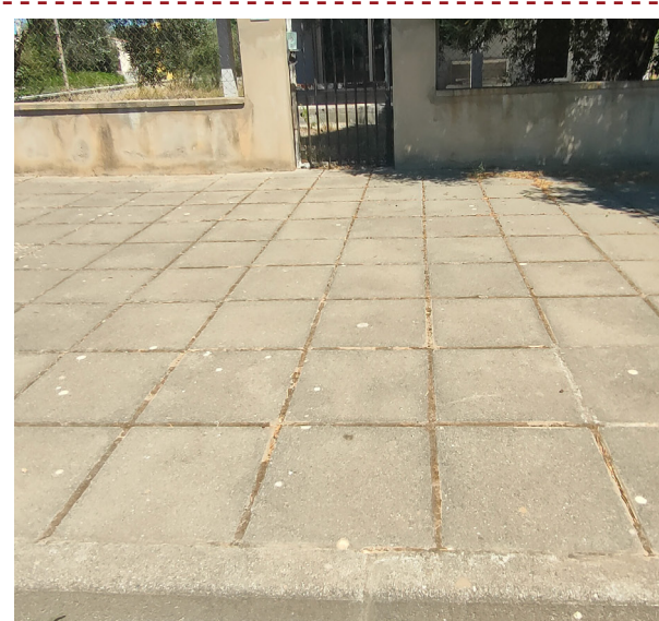
Marciapiedi con pavimentazione in lastre cementizie.
