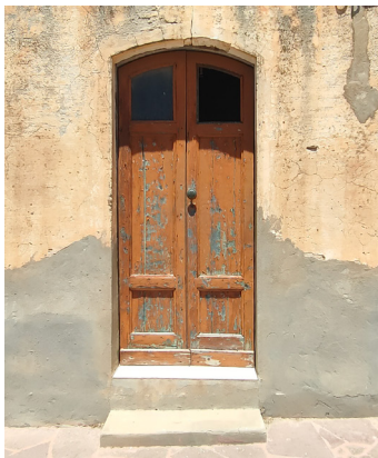
Elemento al di fuori del perimetro del Centro Matrice
