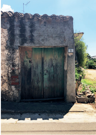
Sistemi statici architravati (Portali in vano proprio)
