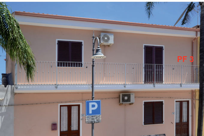
Balcone lineare lungo tutto il prospetto, aggettante con parapetto in ferro
