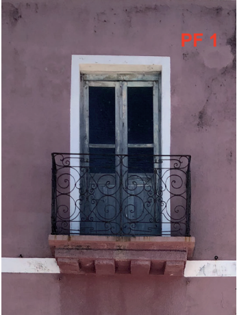
Balcone aggettante con mensola lapidea e parapetto in ferro
