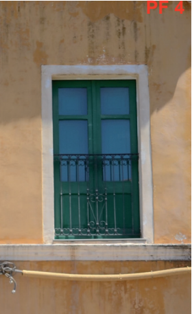
Balcone non aggettante con parapetto in ferro
