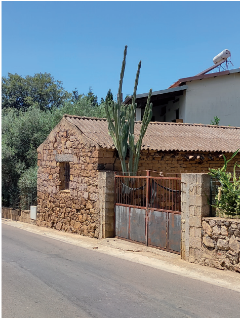
Esterno al centro matrice_Centro abitato Masainas
