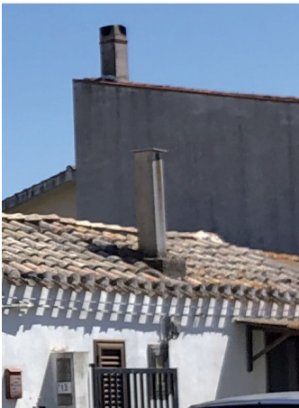
Elemento esterno al centro matrice (Documentazione fotografica 2022)
