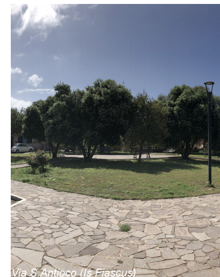
Via S. Antioco (Is Fiascus) STATO ATTUALE - PAVIMENTAZIONE IN LASTRE DI BASALTO
