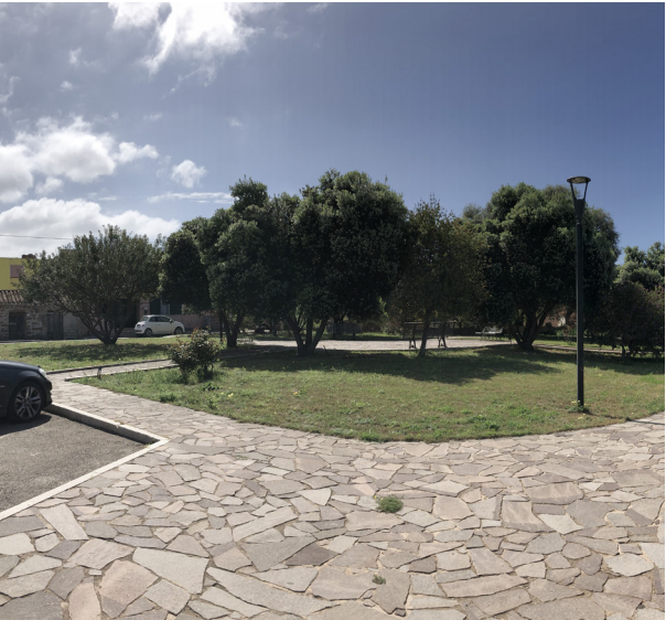
Pavimentazione in lastre di basalto.
