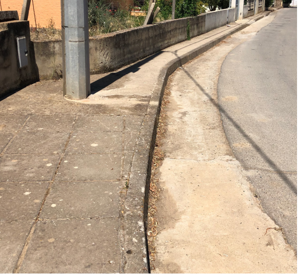
Pavimentazione in cemento.
