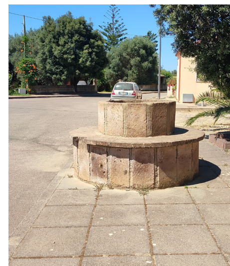
Pozzo con seduta in materiale lapideo.
