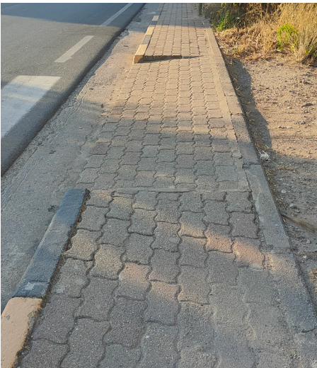
Marciapiede con pavimentazione in mattonelle cementizie.
