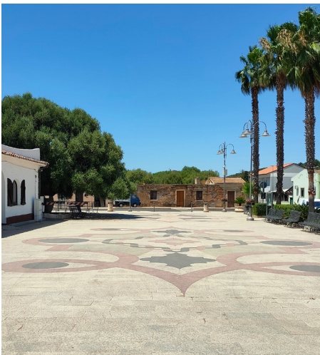
Pavimentazione in lastre di granito, disegno geometrico con cromie differenti.
