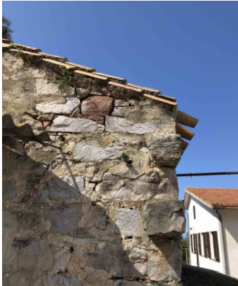
Coronamento con doppia fila di tegole convesse, disposte a filo muro o lievemente sporgenti
