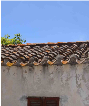
aggetto semplice dei soli coppi canale con smaltimento diretto delle acque
