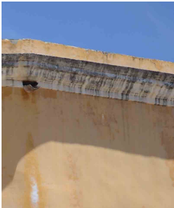
cornice di gronda realizzata in conci lapidei, con muretto d'attico e modanatura con canale di gronda incassato.
