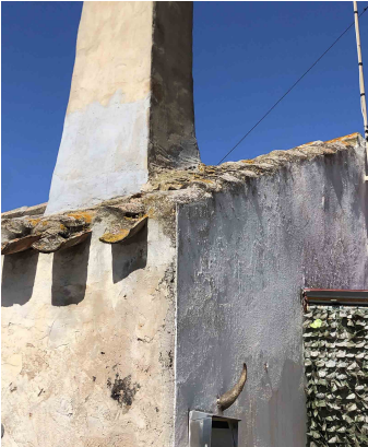
Coronamento con fila di tegole convesse, disposte a filo muro
