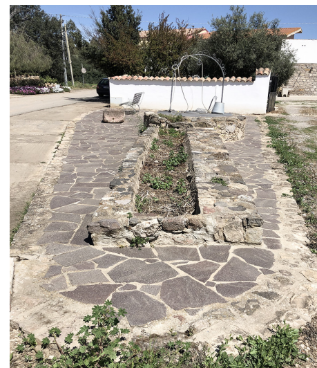
Pozzo in materiale lapideo
