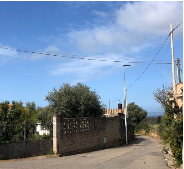
Pavimentazione in conglomerato bituminoso.
