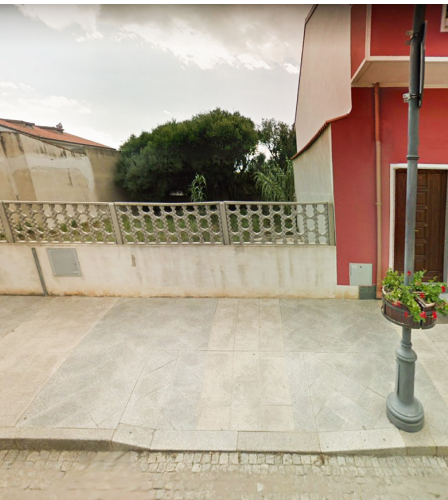
Marciapiedi con pavimentazione in lastre di granito con diverse varietà di posa e colorazione.
