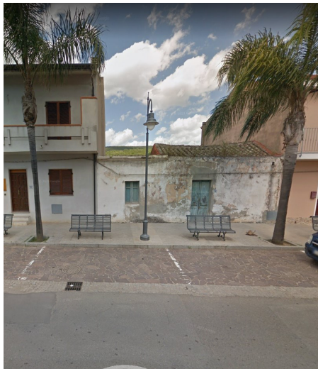
Pavimentazione in lastre di basalto, messa in opera opus incertum; cunette in cubetti di granito 10x10cm.
