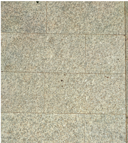
Pavimentazione in lastre di granito.
