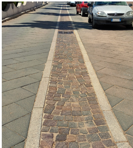
Pavimentazione in lastre regolari di basalto posate simmetricamente con scolo delle acque centrale in cubetti lapidei e lastre di granito.
