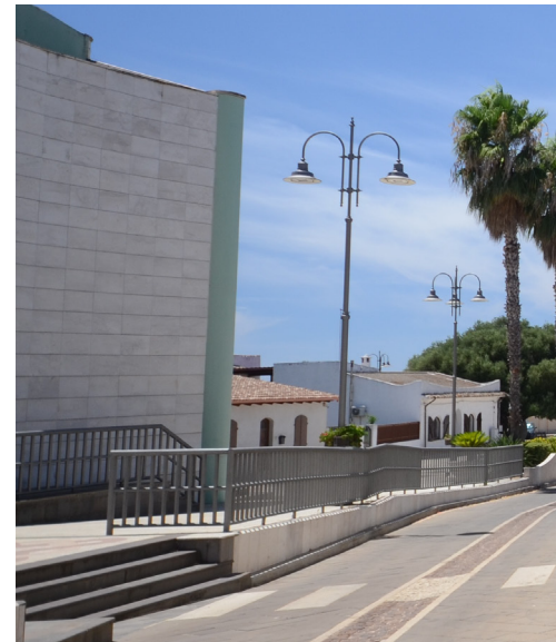
Corpo Illuminante Tipo A (Strade centro storico e piazza chiesa)
