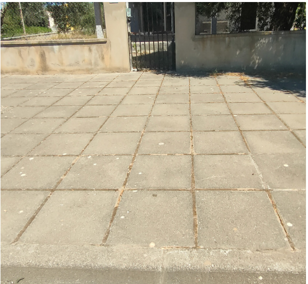
Pavimentazione in lastre cementizie.
