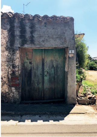
Sistemi statici architravati (Portali in vano proprio)
