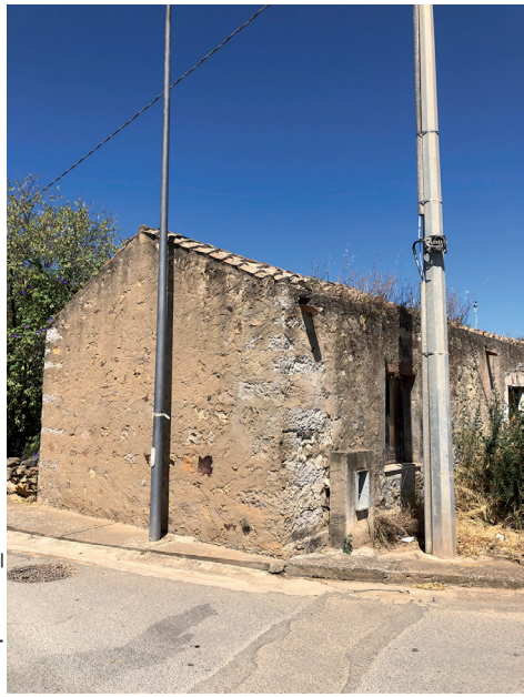
Unità edilizia trattata con intonaco rustico
