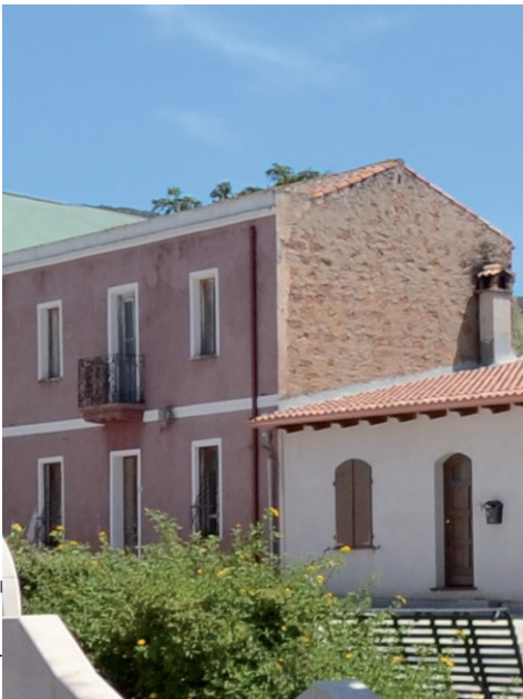
Palazzotto trattato con intonaco liscio nella facciata principale e con la tecnica "raso pietra" in quella laterale
