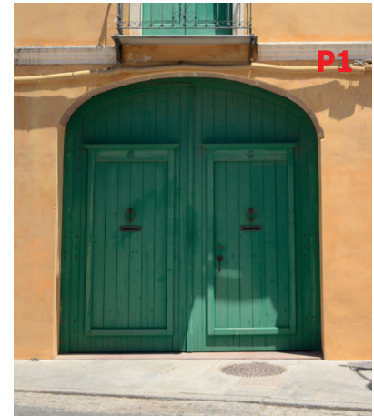
Sistemi statici spingenti (Portali inseriti nel corpo di fabbrica)
