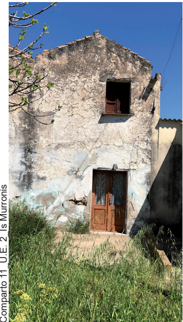
Unità edilizia trattata con intonaco liscio
