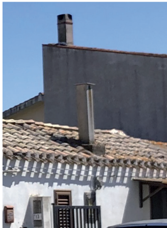
Elemento esterno al centro matrice (Documentazione fotografica 2022)
