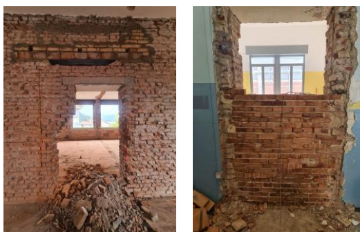
Apertura e tamponamenti pareti portanti in muratura
