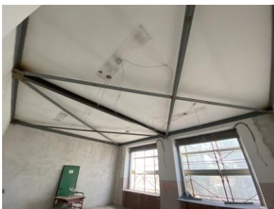
Rinforzo proposto per gli impalcati: GFRP, Acciaio, Legno
