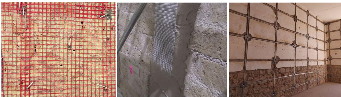
Rinforzi proposti per le pareti: GFRP, FRCC, CAM
