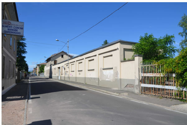
Fronte OVEST su Via Alessandro Volta
