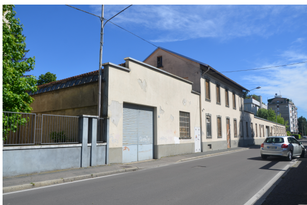
Fronte OVEST su Via Alessandro Volta
