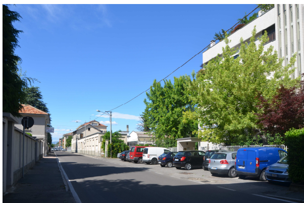
Fronte OVEST su Via Alessandro Volta
