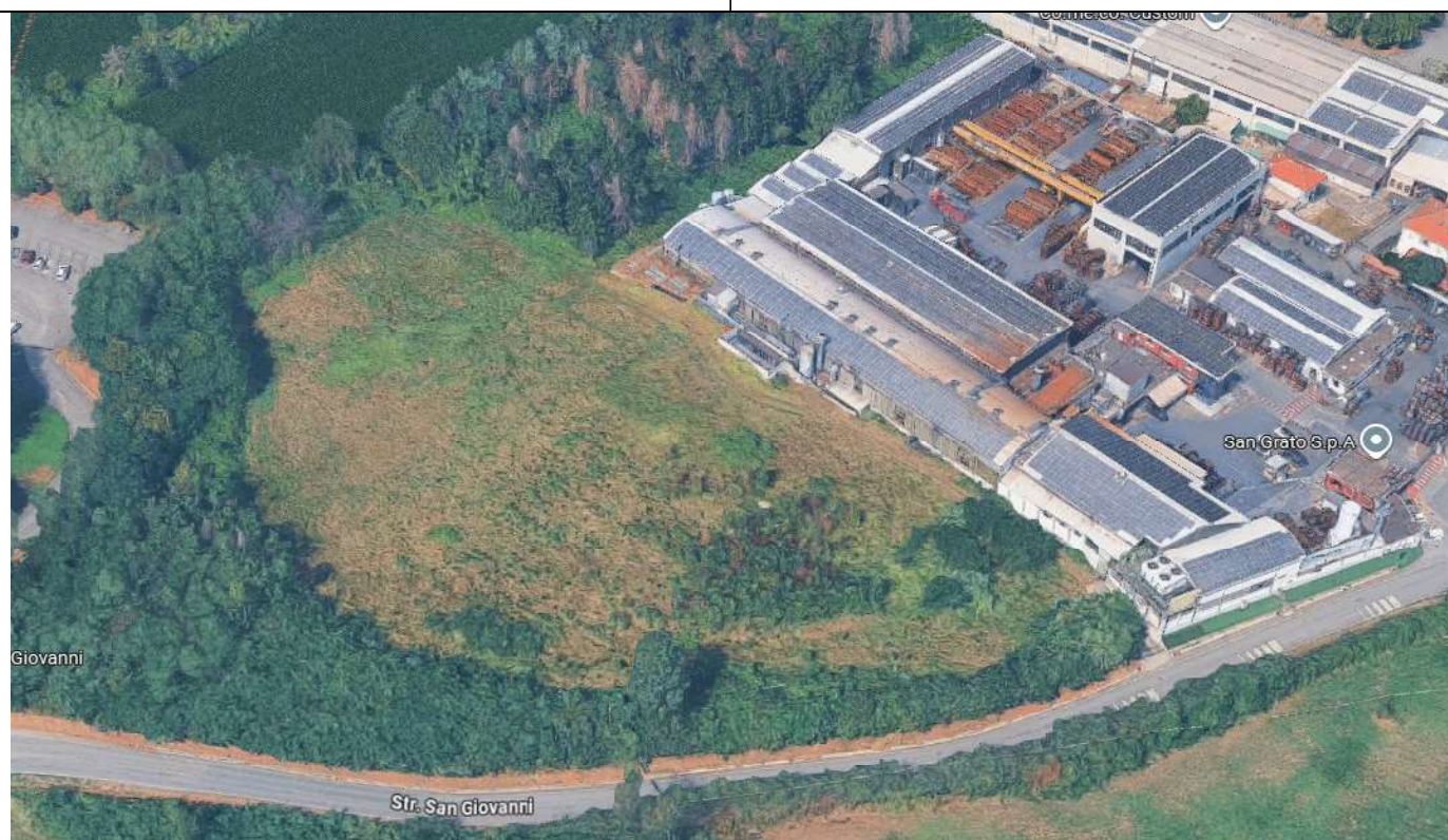
Vista aerea del fronte sud dello stabilimento San Grato
