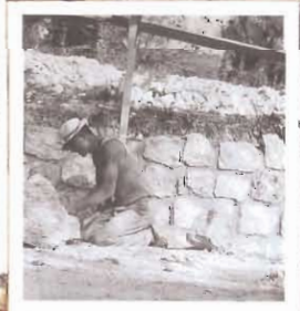
Anno 1959 - Achille Tosi, nato il 6 aprile 1916 a Montone ed emigrato a Nizza nel 1957. Scarpellino, ha lavorato con la più grossa ditta di lavori pubblici della città (Entreprise Nicotetti) la quale ha curato la costruzione di grandi strade e dei muri di sostegno in pietra, come le «voie rapides» di Nizza.
