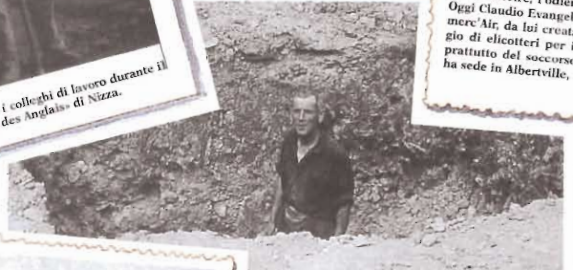
Anno 1965 - Sebastiano Evangelisti, nato a Città di Castello il 3 aprile 1921, emigrato a Nizza nel 1957. Muratore, al lavoro di scavo delle fondamenta di una casa.
