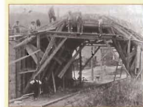
Anno 1935. Costruzione del ponte S.S. 3 Bis sopra la ferrovia dell'Appennino
