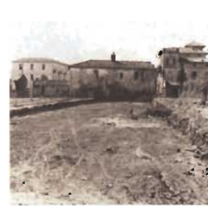
Anno 1958. Costruzione del primo tratto del viale Unità d'Italia. Al centro la casa della «Commenda» che verrà demolita (Archivio fotografico comunale)
