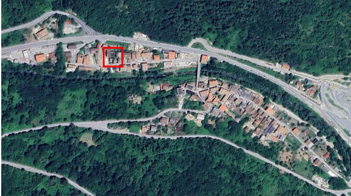
F.2 _ Foto aerea dell'abitato di Trisungo (Google Earth) e localizzazione dell'Aggregato A – Casa Fiori
