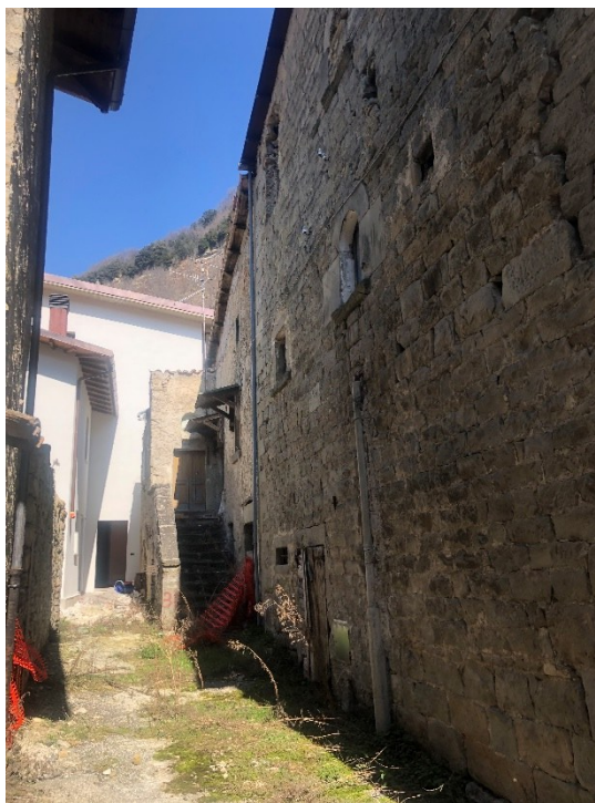
F.8_Prospetto ovest_in primo piano particella 31 di Casa Fiori_sullo sfondo particella 30
