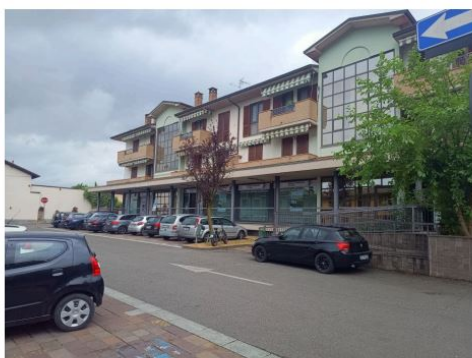
Vista stradale di Via Umberto Primo n. 4 - 6
