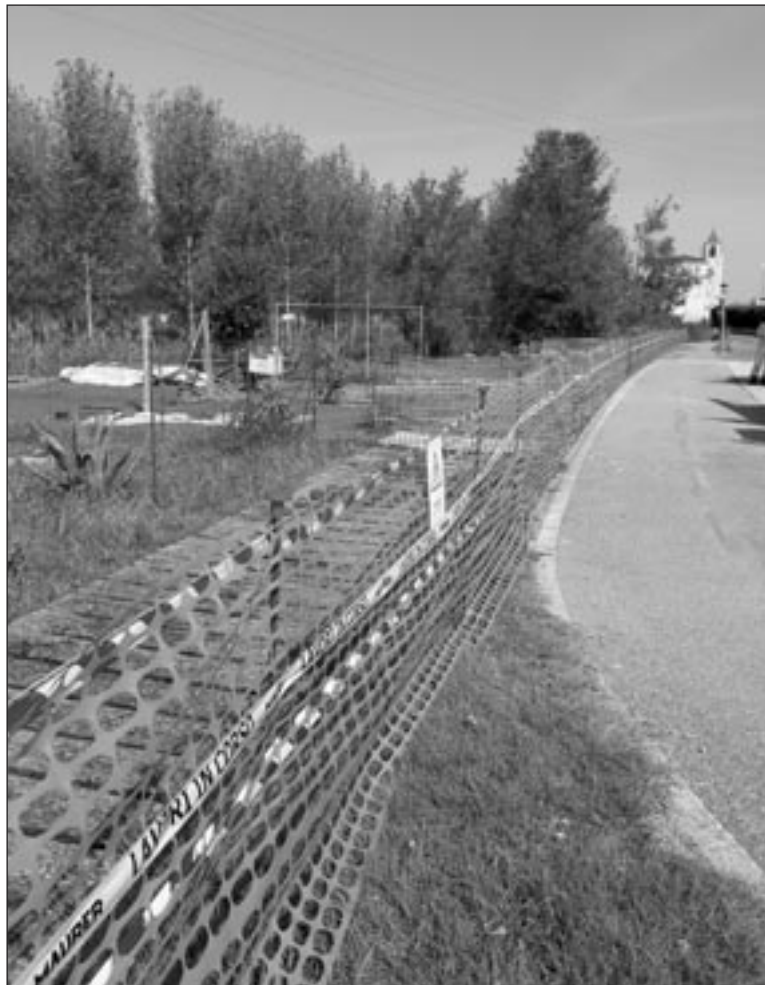
Il cantiere aperto in via Mezzavilla a Bonferraro
