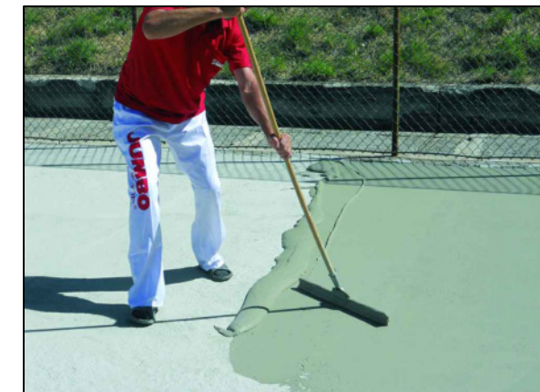
Applicazione di resine per pavimenti sportivi
