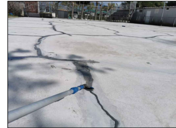
Applicazione di malta tecniche sulle zone fessurate del campo
