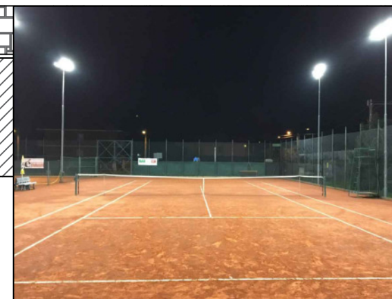
Installazione nuovi proiettori led per impianti sportivi
