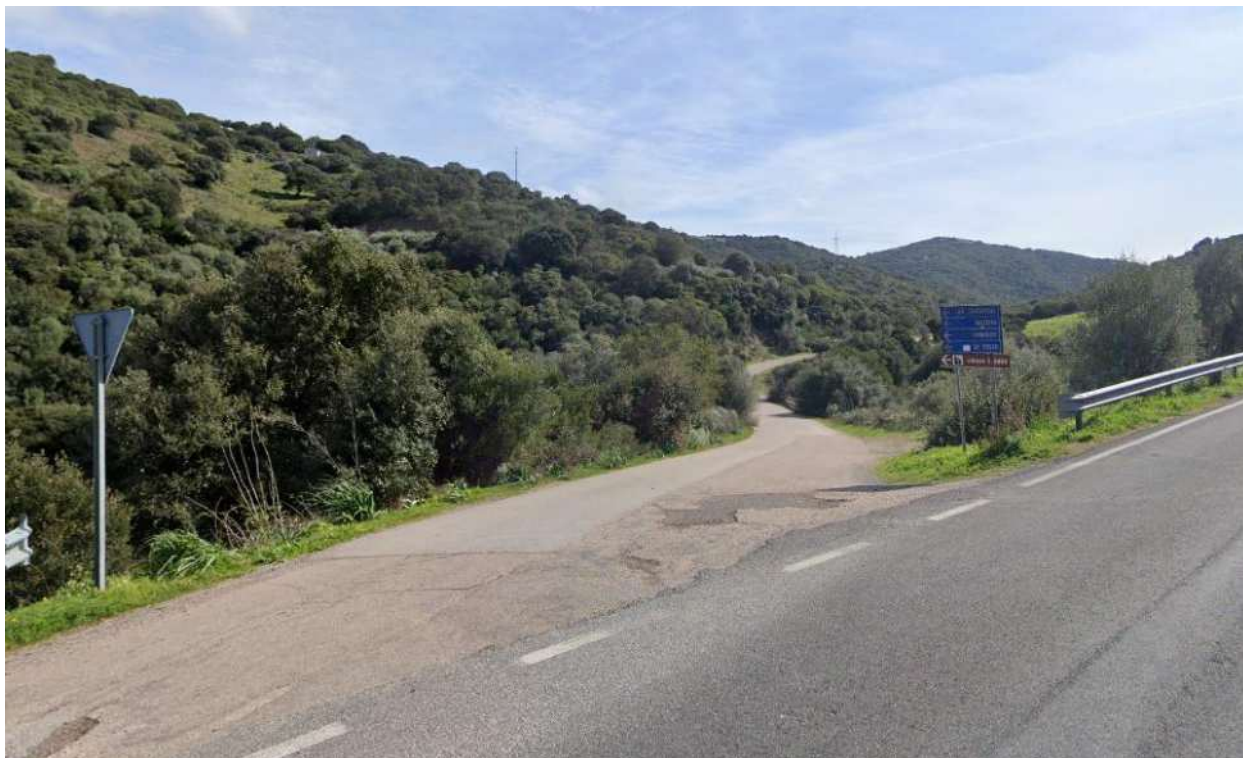
Bivio SP2 - Lumbaldu (Inizio Strada a nord)
