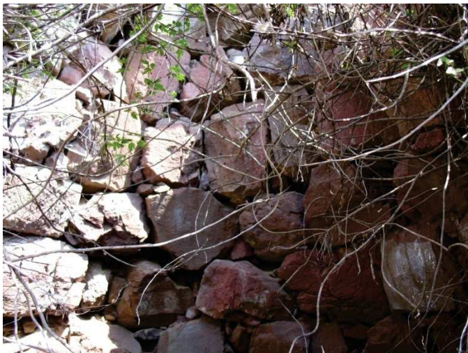
Foto N°3. Nuraghe Paltuso: particolare del paramento murario della tholos.
