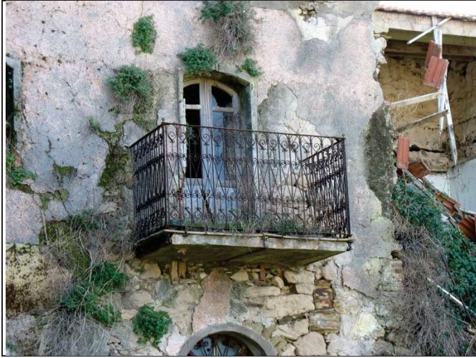
Foto N°14. La Muddizza: Domo Lepori, particolare della ringhiera del poggiolo.
