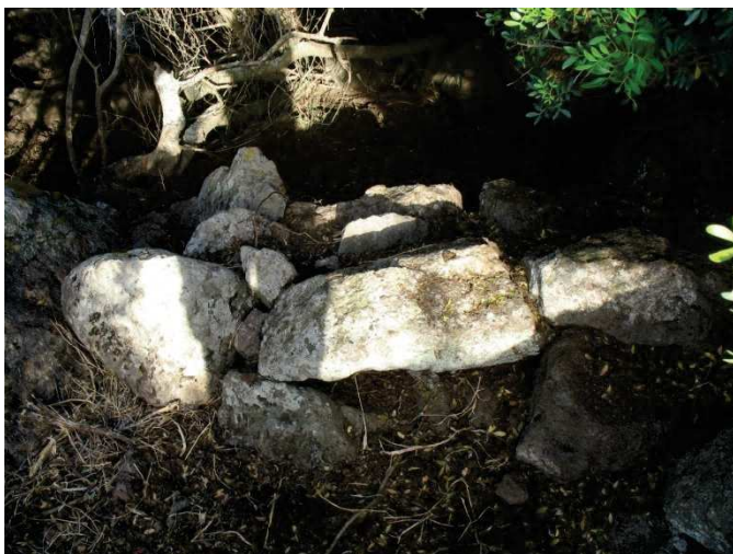
Foto N°12. Figù: particolare degli allineamenti murari.
