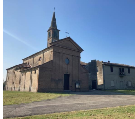
Fonte: sopralluoghi gruppo PUG
