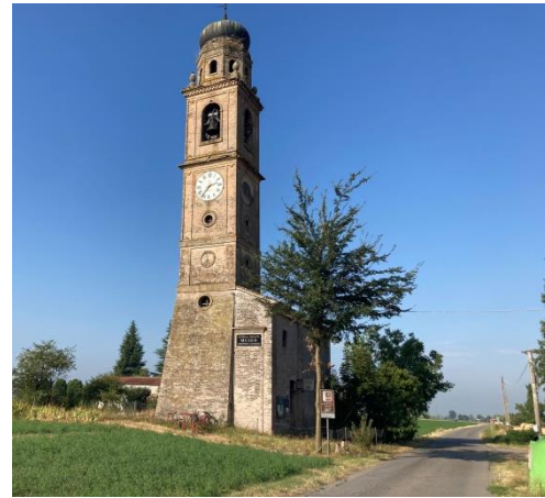
Fonte: sopralluoghi gruppo PUG
