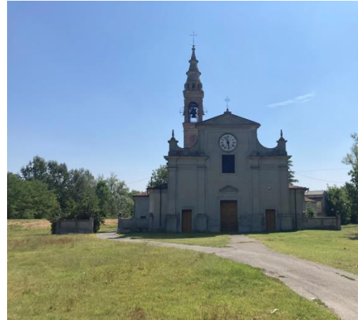
Fonte: sopralluoghi gruppo PUG
