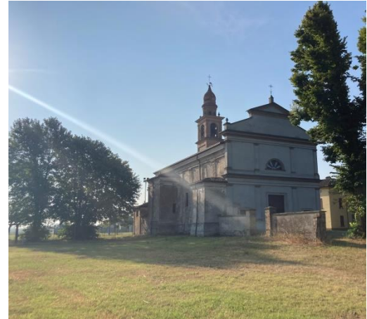
Fonte: sopralluoghi gruppo PUG
