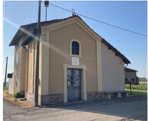
Fonte: sopralluoghi gruppo PUG
