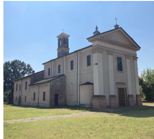
Fonte: sopralluoghi gruppo PUG
