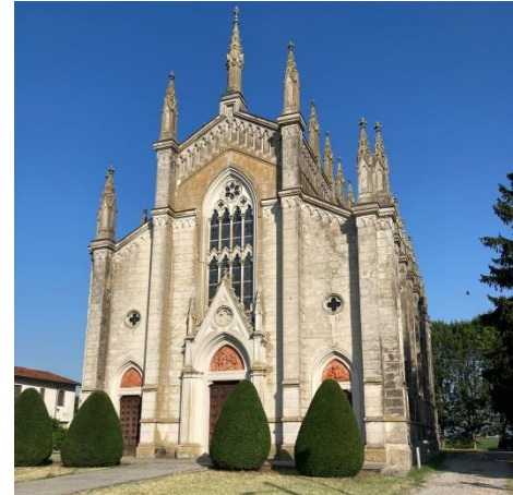
Fonte: sopralluoghi gruppo PUG
