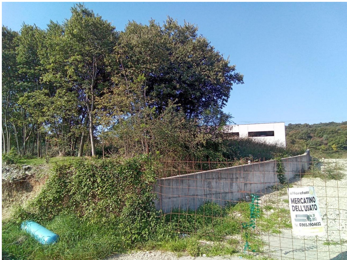
PUNTO DI PRESA 01: FOTO 1/A
