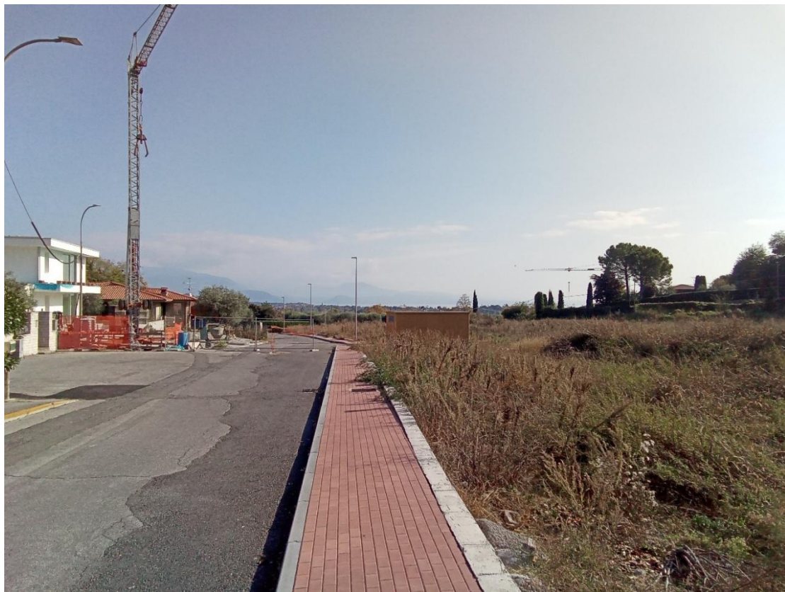
PUNTO DI PRESA 02: FOTO 02/B
