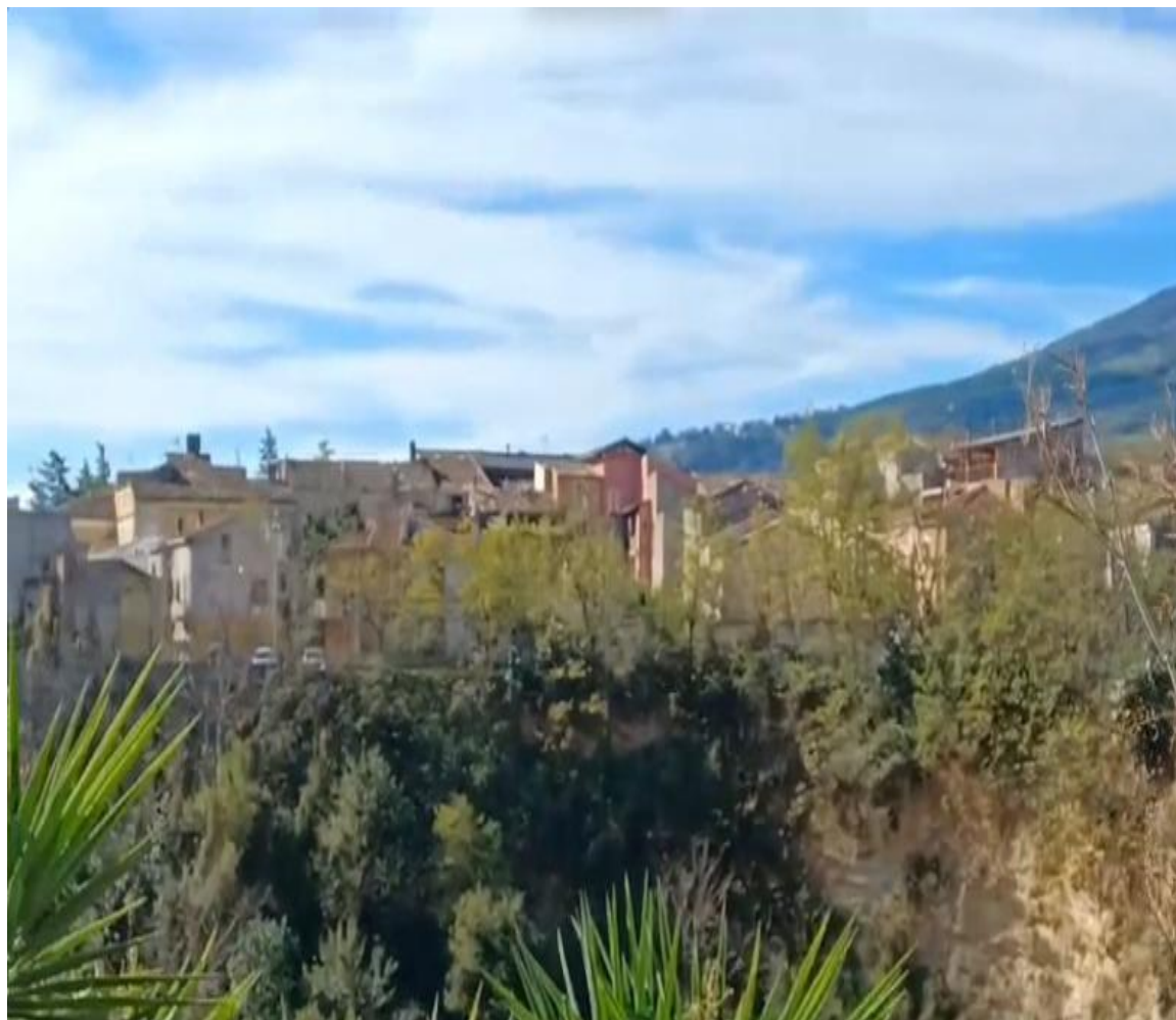
Figure 3 PUNTO CRITICO 1 AL 19.07.2023
