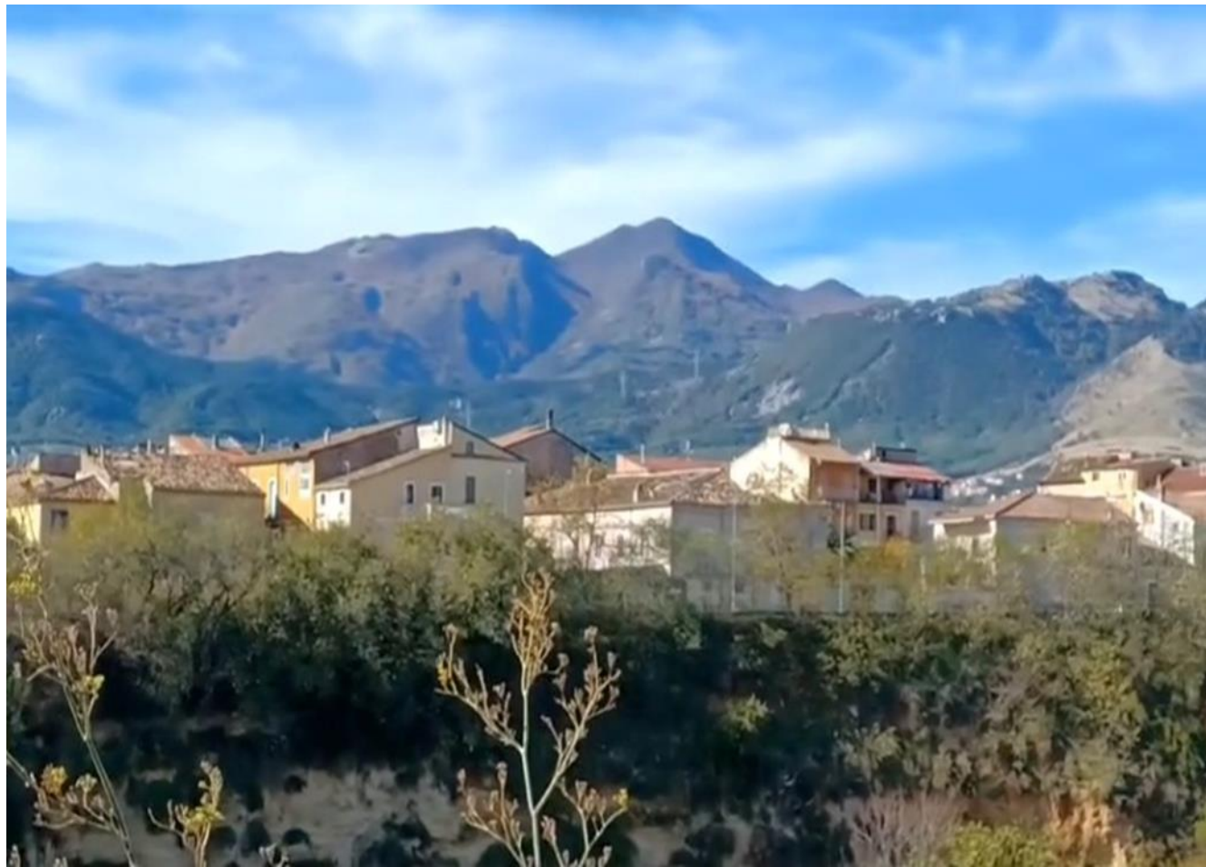
Figure 6 PUNTO CRITICO 2 AL 19.07.2023
