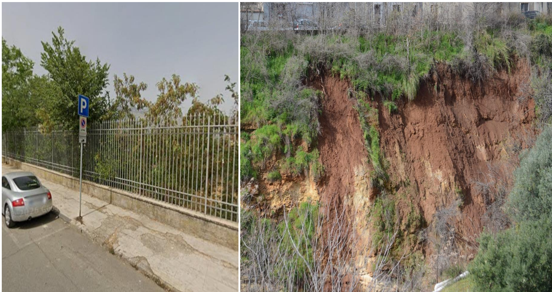
Figure 5 PUNTO CRITICO 3 AL 15.02.2026
