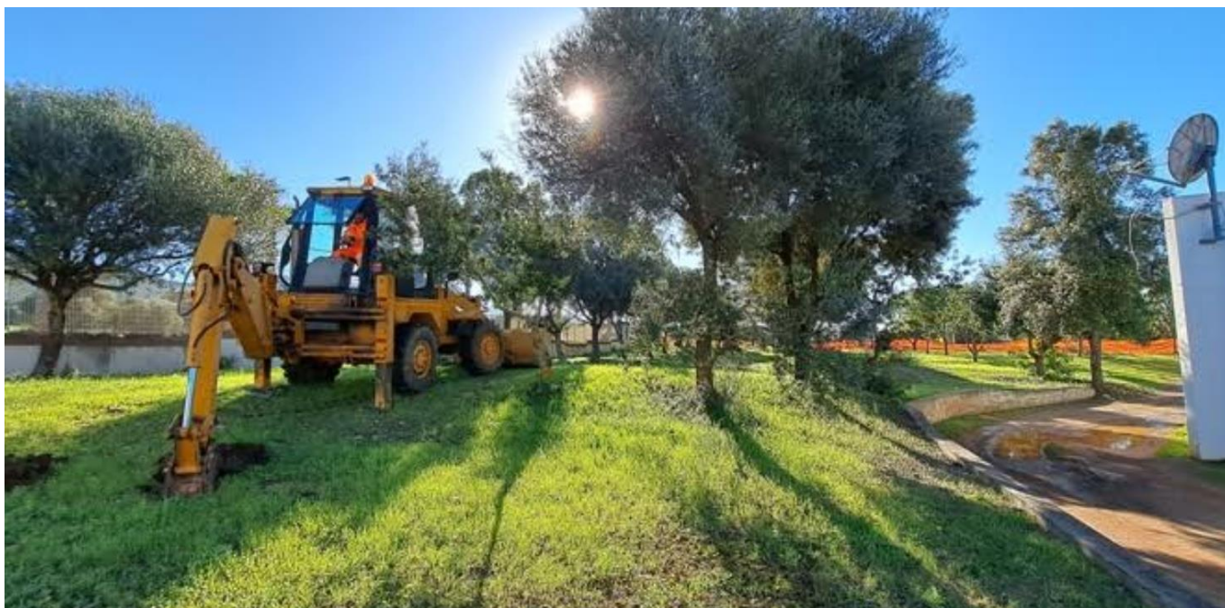
Fig. 13 Pozzetto geognostico Pz1
