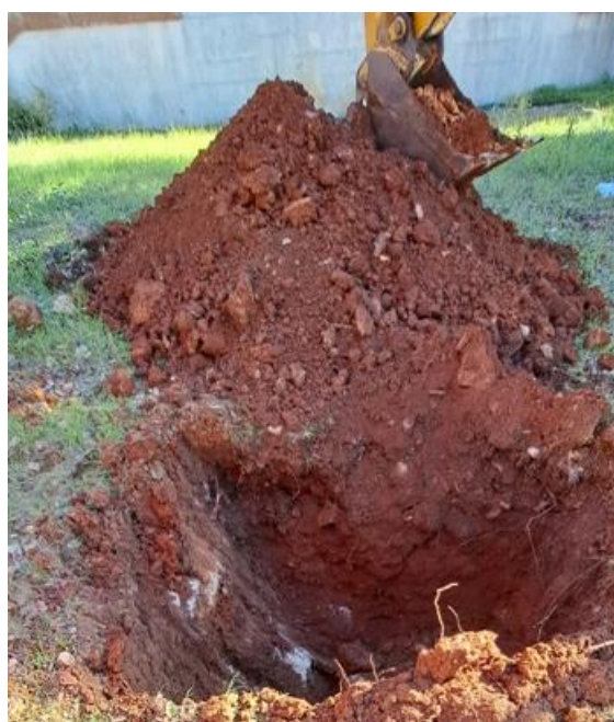
Fig. 14 Pozzetto geognostico Pz2
