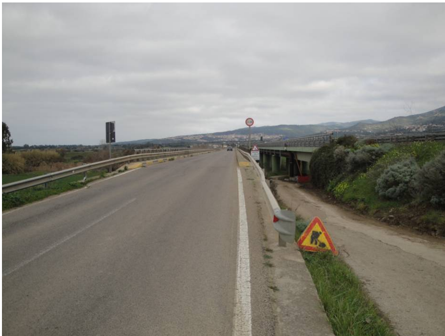
Ponte di valle sul fiume Coghinas
