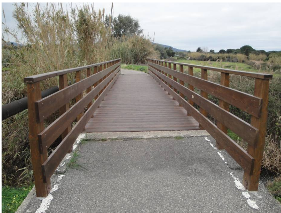
Ponte pedonale/ciclabile in legno
