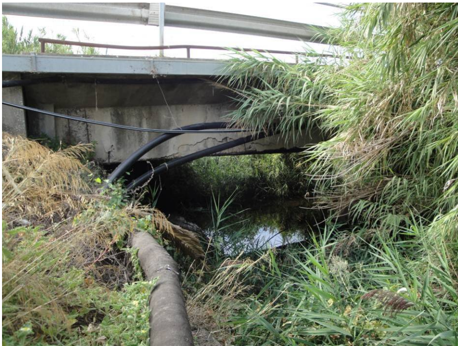
Ponte carrabile sulla SP n.90
