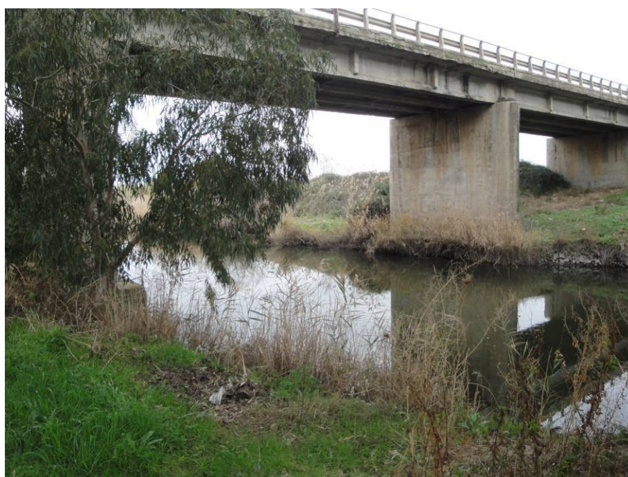
Fiume Coghinas sotto il ponte di valle
