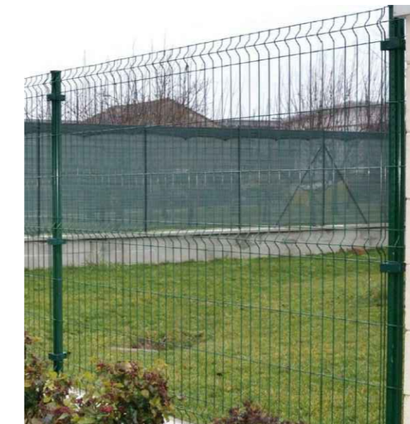
TIPOLOGIA RECINZIONE IMPIEGATA
