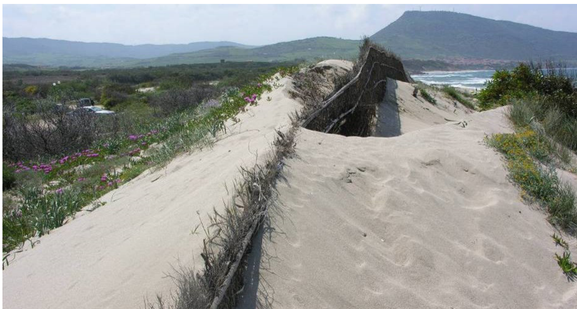
Figura 13. Particolare del cordone dunare “imbrigliato” immediatamente oltre il lungomare: si noti la presenza della barriera verticale in frasche che determina un forte accumulo di materiale sabbioso. Tale processo sottolinea la potenzialità del sistema di spiaggia circa lo sviluppo di coperture dunari là dove venga garantita la continuità trasversale della spiaggia e l'assenza di infrastrutture
