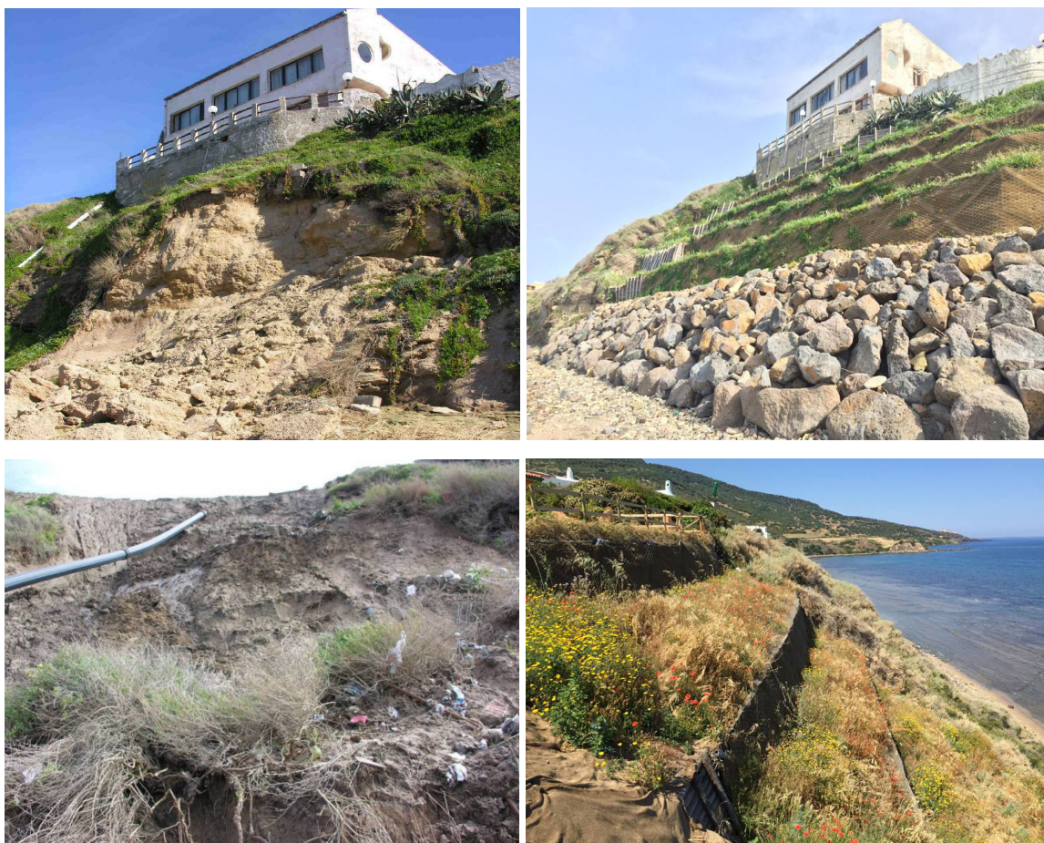
Figura 23. Tratti della scarpata di La Ciaccia pre e post interventi di stabilizzazione dei versanti in frana
