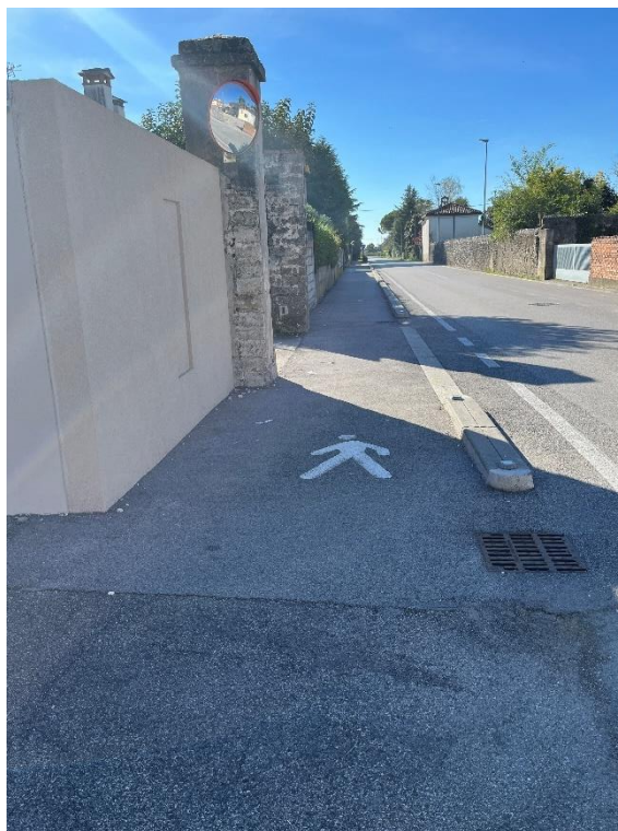
Figura 13: Tratto finale di Via San Giovanni – percorso pedonale esistente.
