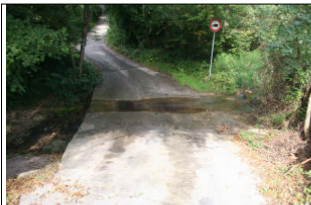
Attraversamento di via Casneti Bassi sul Bragazzo.
