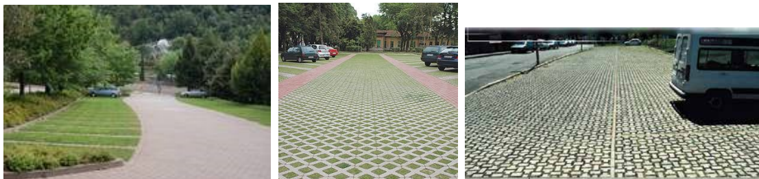
Figura 34 - Esempi di pavimentazioni permeabili
