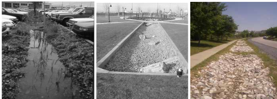
Figura 28 – Esempi di trincee d’infiltrazione
