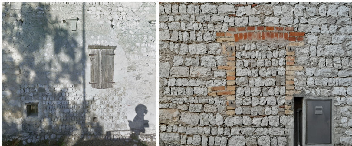
(via Nannavecchia e via De Bortoli, Santa Foca) Esempi positivi di tamponamento, in cui risultano chiaramente leggibili i fori originari.
