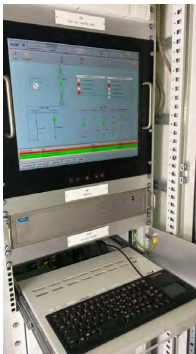
Figura 44: Esempio di quadro rack per SCADA e comunicazione
